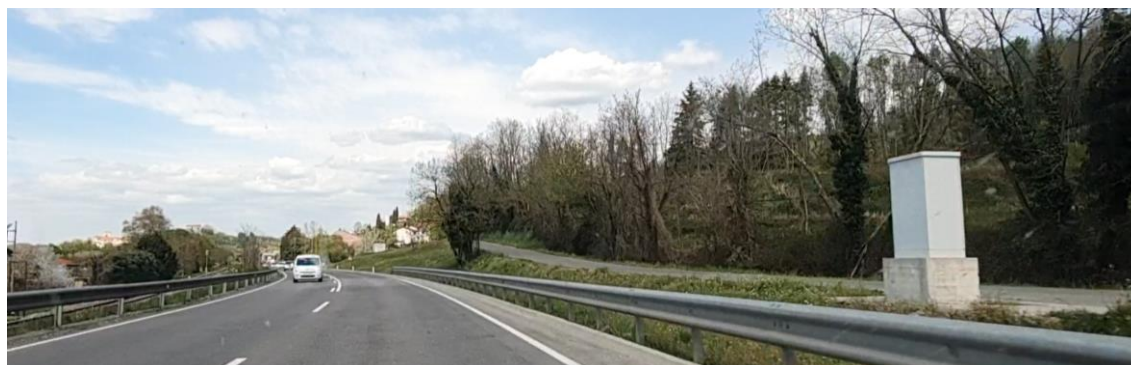
Slika 2: pogled na območje OPPN s šempetrske obvoznice
